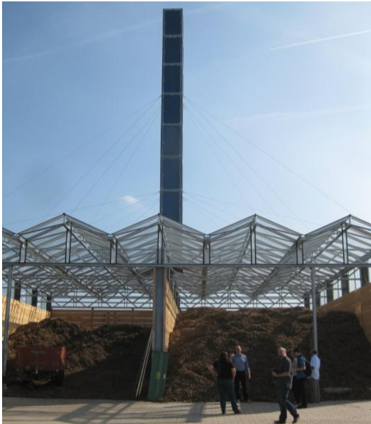
Abbildung 53: Biomasselager mit solarer Trocknung und Solarkamin am Campus Klein-Altendorf [42]
