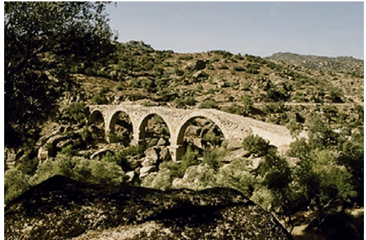
Römische Aquäduktbrücke bei Alabanda (Türkei)
