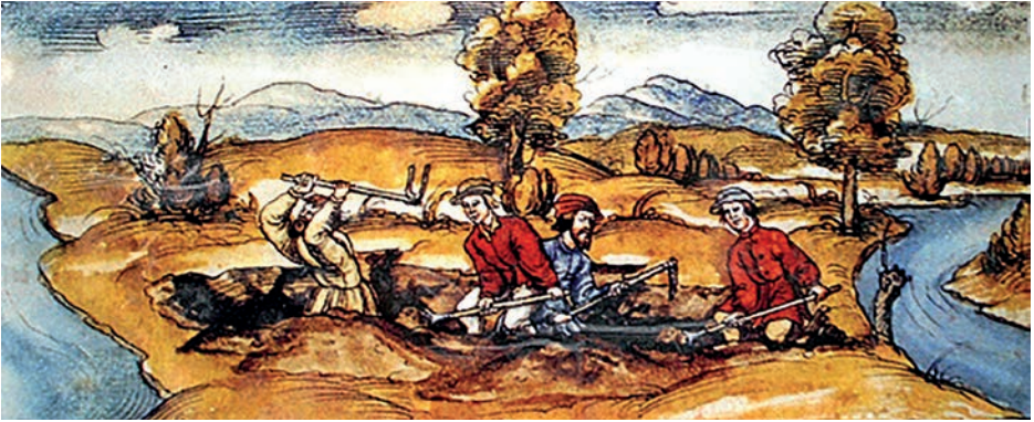
Bau des Karlsgrabens als früheste Verbindung zwischen Rhein, Main und Donau unter Karl dem Großen in Angriff genommen (aus der Chronik der Bischöfe von Würzburg 1546)
