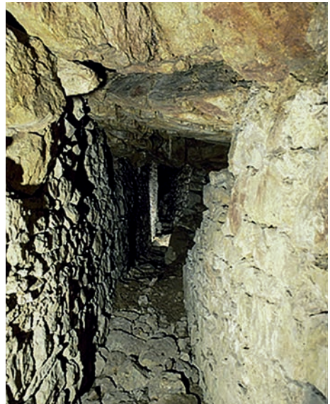
Blick in den Blankenheimer Tiergartentunnel kurz nach der Wiederfreilegung 1997
